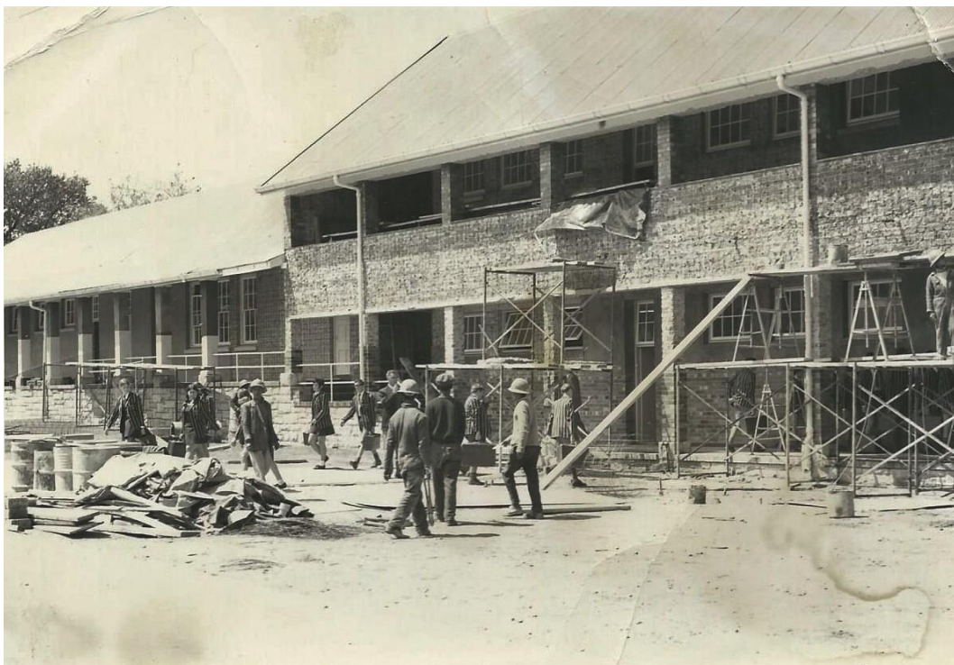
Herstel van skoolgebou
